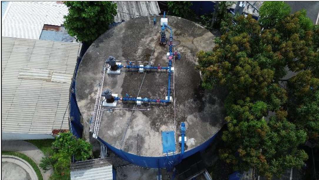
Imagen 28. Vista aérea de Tanque Nueva Cayalá
