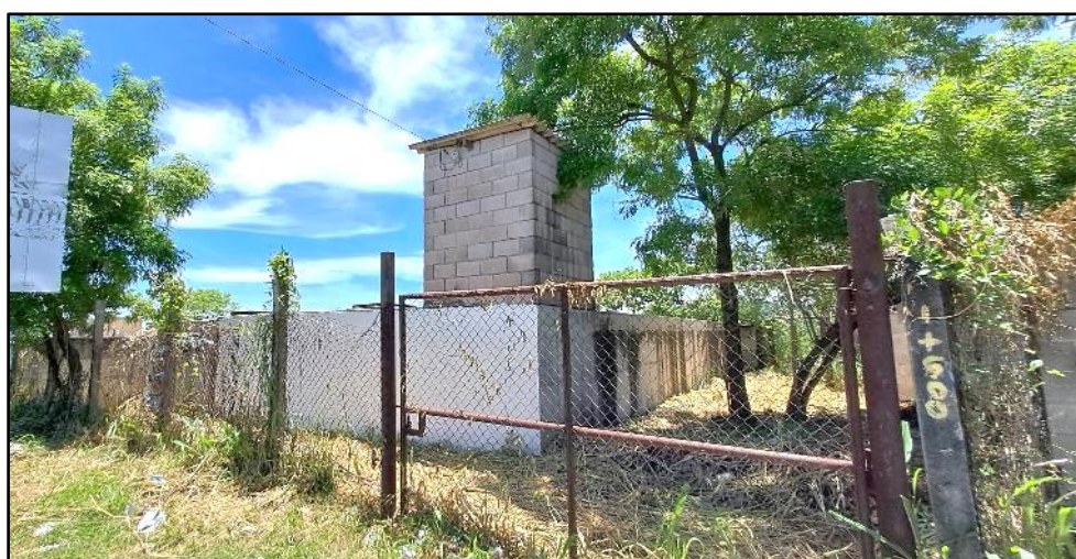
Imagen 24. Fachada de Tanque Corinto
