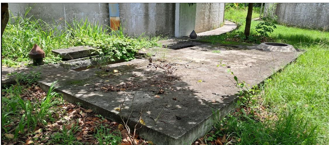
Imagen 23. Cajas para rehabilitar tapaderas
