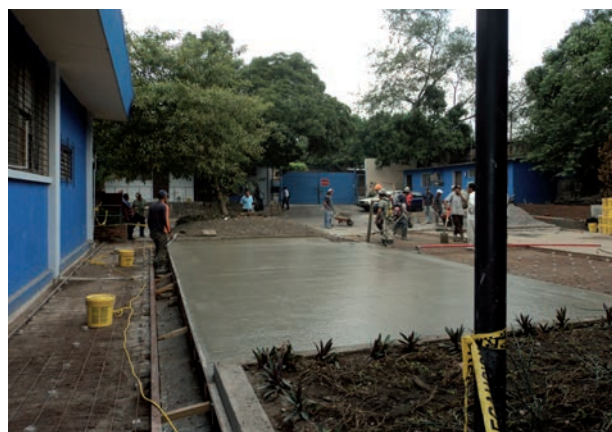
REMODELACIÓN DE LA INFRAESTRUCTURA PLANTEL EL CORO
