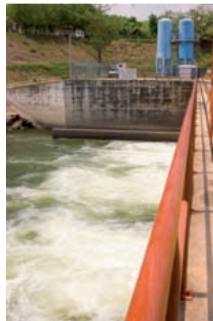
Planta Potabilizadora Las Pavas
