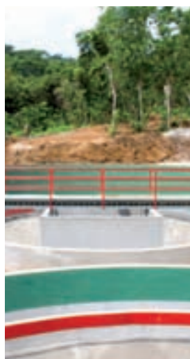
Planta de Tratamiento, Juayúa
